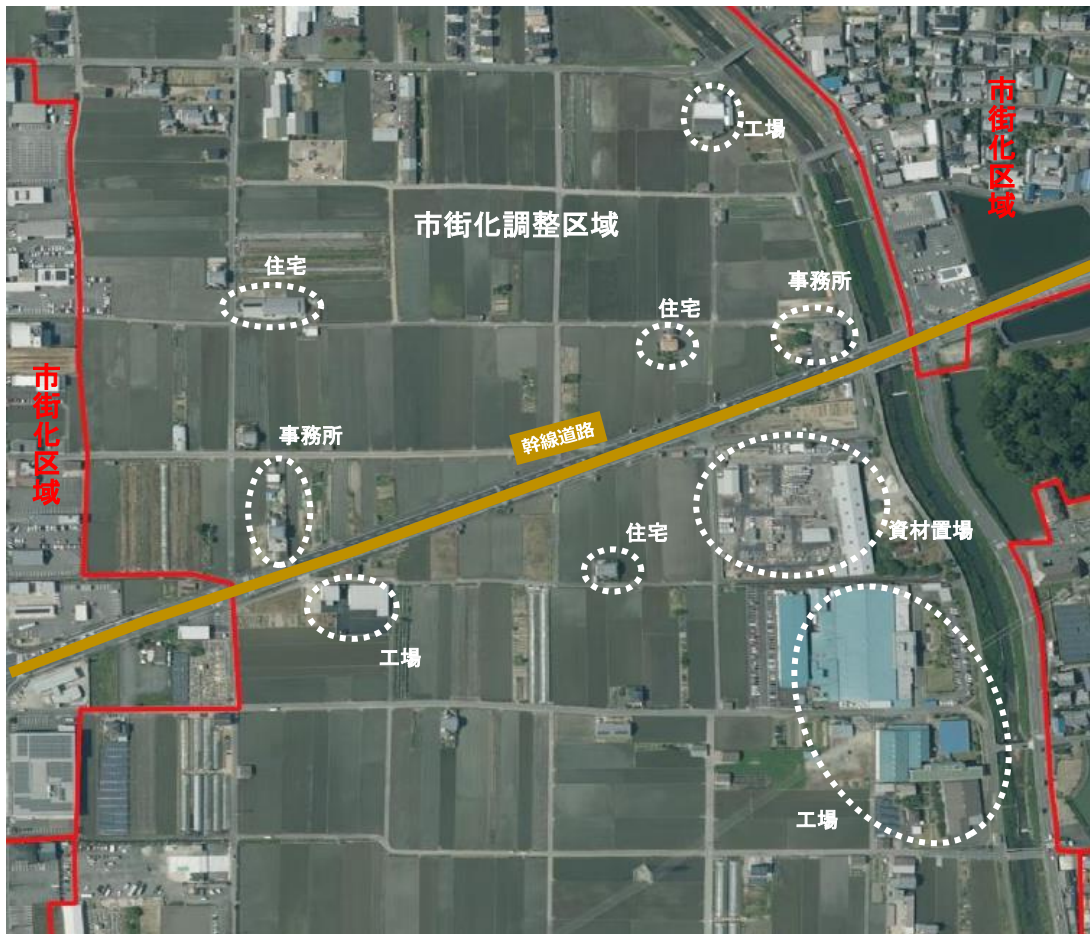
◆図表 2-9-3 奈良県幹線道路沿道の市街化調整区域での開発状況（ケース 2）
